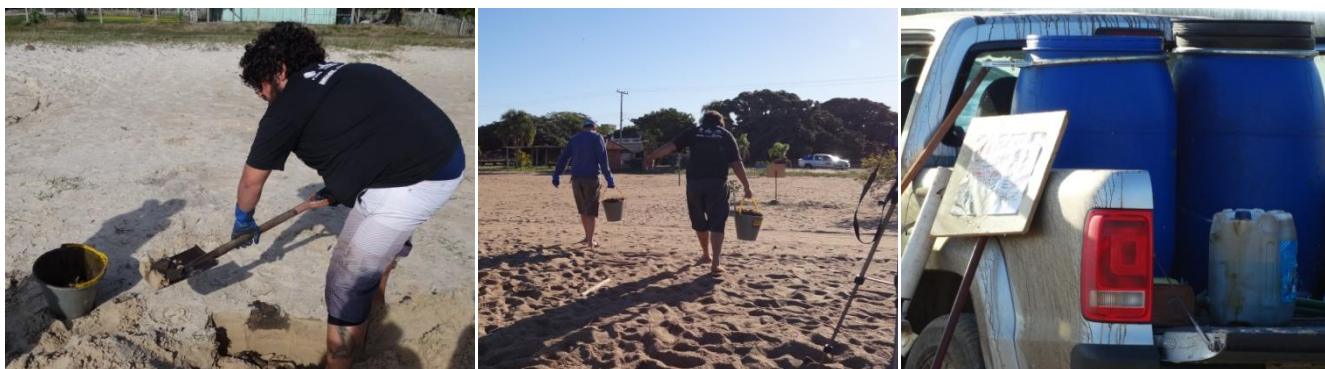
Figura 18: Remoção do sedimento contaminado. O resíduo foi transportado em baldes até tambores, onde foi armazenado e transportado até o Laboratório de Oceanografia Geológica para destinação final
